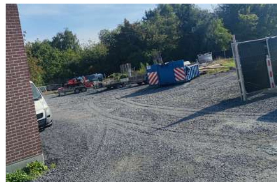
Le hall technique où des aménagements sont prévus.
