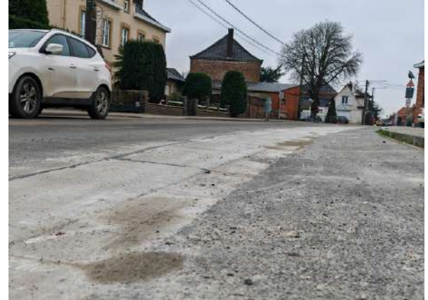
Les travaux sont à présent terminés à Pottes.
