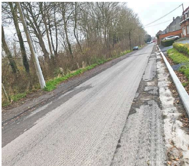
La dernière phase des travaux interviendra au printemps 2025.
